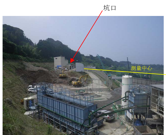
【仮設ヤード全景】
