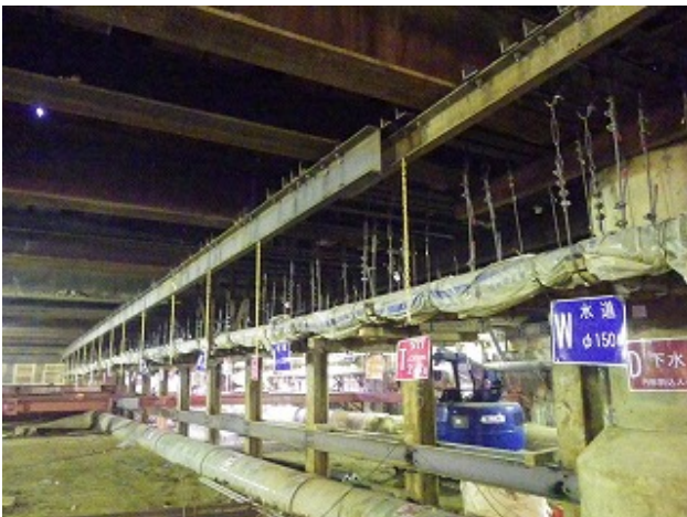
埋設物 吊り防護状況
