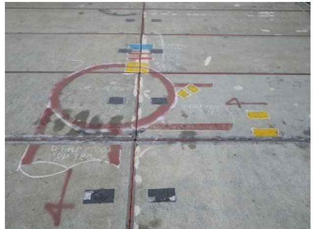
埋設物位置路面マーキング
