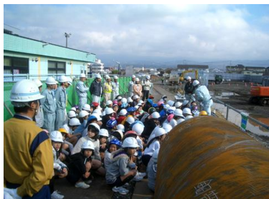
活動名:高架橋作業所での現場見学会
