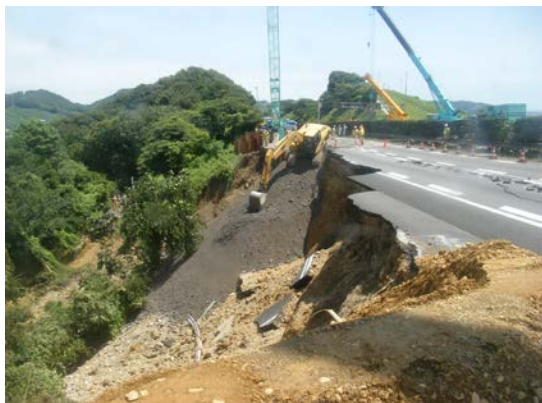
活動名: 東名高速の応急復旧工事
