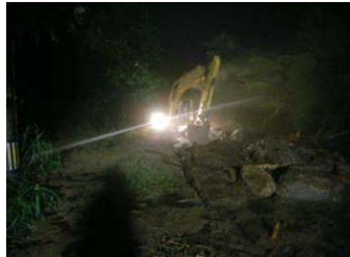
活動名:国道の復旧作業
