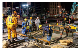
▲砕石にセメントを混ぜたものを下地にしていきます。セメントを混ぜることで砕石が固結され、基礎ブロックが動くことを防止しています。
