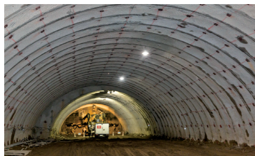
吹付コンクリート、ロックボルト打設後の坑内
