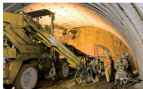
ドリルジャンボでの削孔作業
