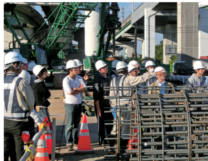
名二環名古屋西JCT工事(平成27年11月5日)
