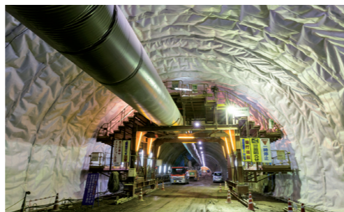
防水シート用の足場を使い防水シートを設置
