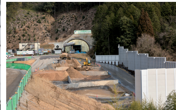
防音壁が立つずり置き場
