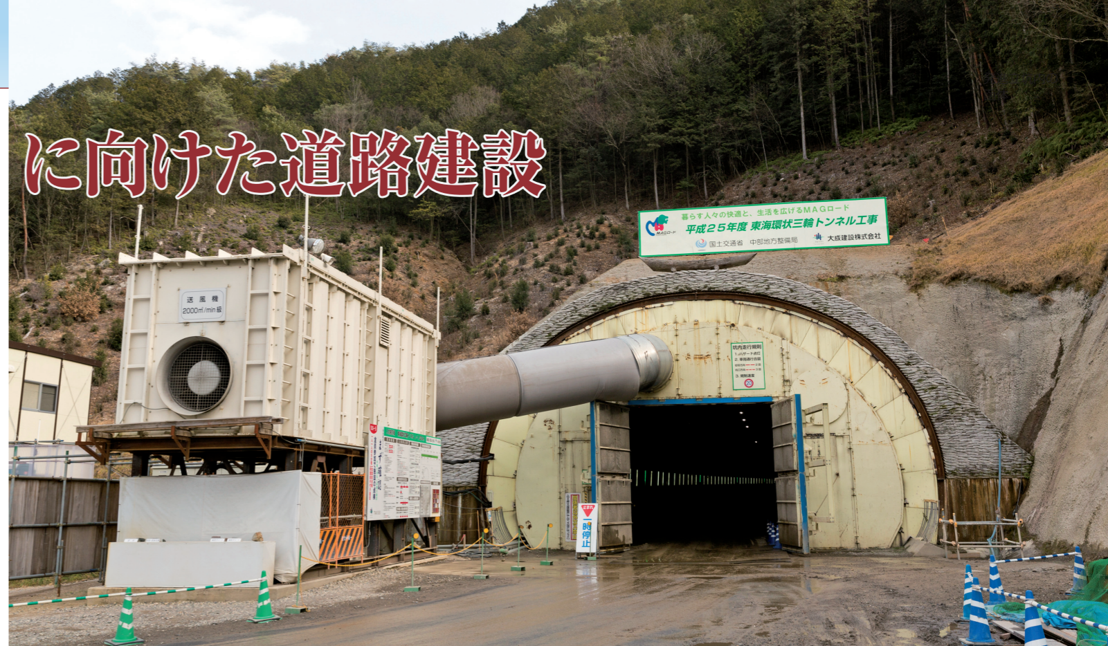
防音扉を設置した起点側西坑口
