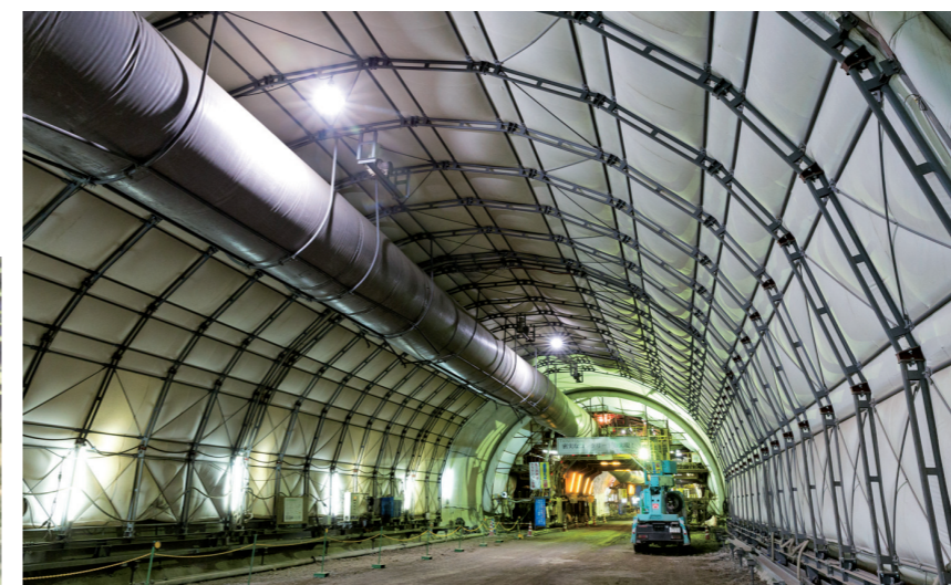
養生中の覆工コンクリート
