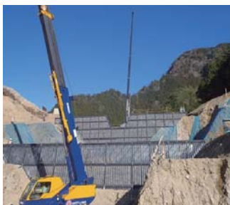
鉄製枠設置状況 24.2.20
