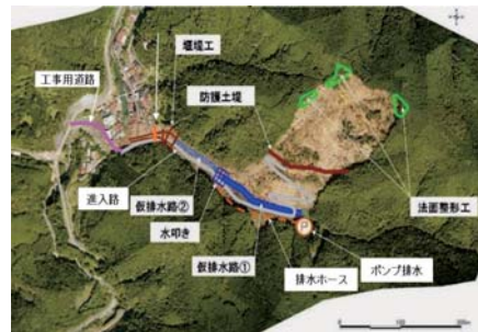
現地の工事状況
