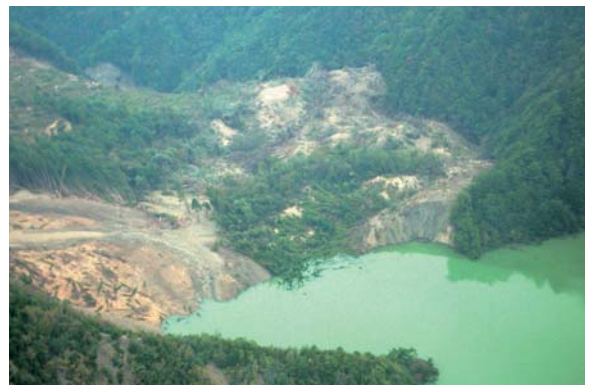
写真② 天然ダム発生時状況 23.10.13
