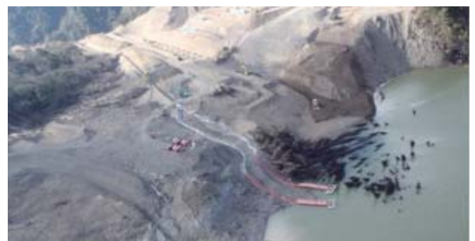
写真④ 現況上空写真(天然ダム呑み口側) 24.1.31
