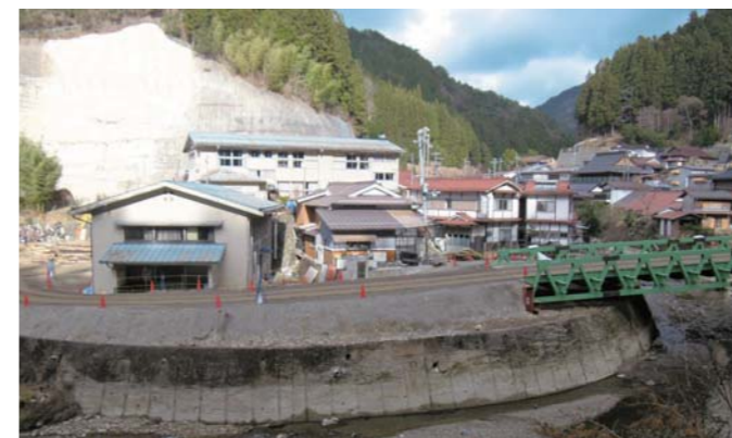
北股地区の仮栈橋と工事用道路 23.12.5
