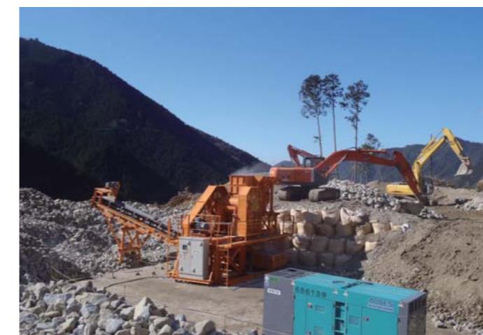
破砕機による栗石生産(熊野) 24.2.9
