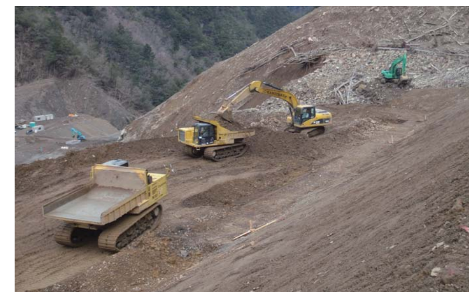
法面安定化のための掘削状況(赤谷) 24.3.1
