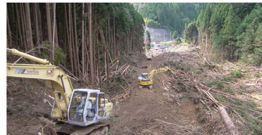
倒木伐採による工食用道路の造成(北股) 23.10.3
