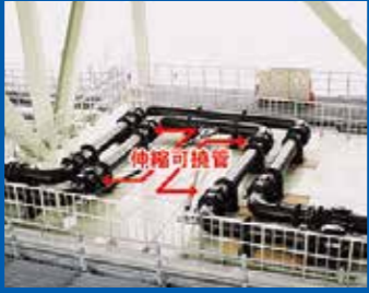
可換管(かとうかん)を配した大伸縮装置により、寒暖差による伸縮や強風の揺れに対応。最大160cmの伸縮に耐えられる設計。
