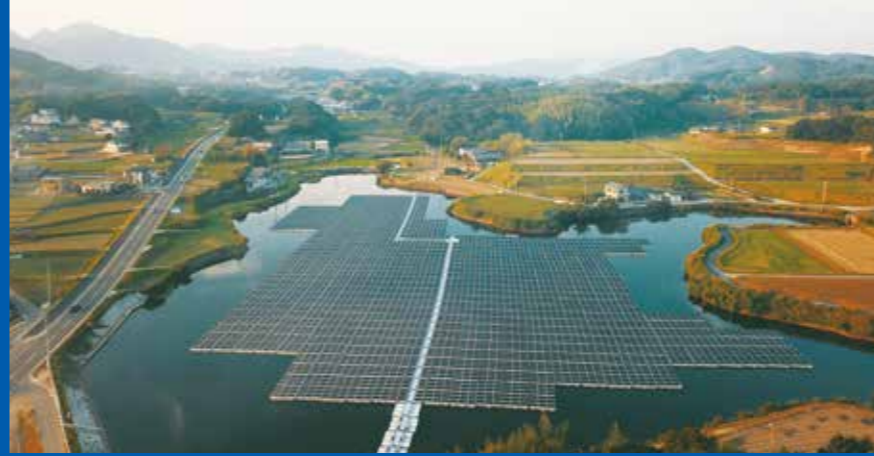
ため池ソーラー発電を行う、洲本市の三木田大池(龍谷フロートソーラーパーク洲本)
