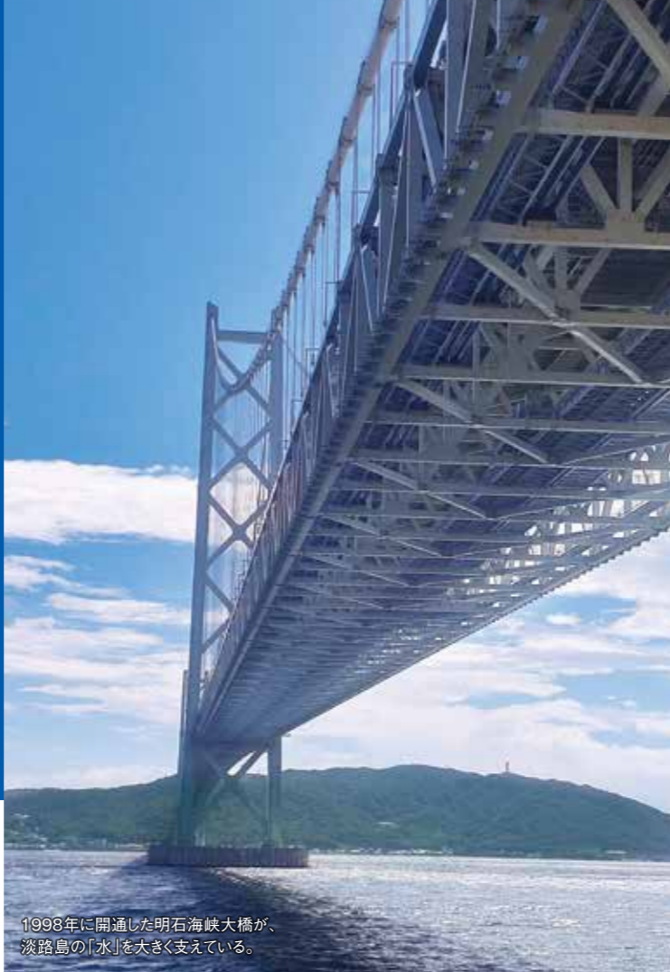
明石海峡大橋には2本の送水管が通され、常時、神戸方面から送水されている。
