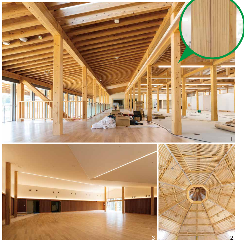
1.「組立柱」と「合わせ梁」で建てられた執務棟。「組立柱」は近くでじっくり見ないと継ぎ目が分からない。2.議会棟2階の議場の天井は鉄骨の梁が使われている。八角形の各隅から登り上がる梁が「蕪束(かぶらづか)」と呼ばれる中央の真束で釣り合いを取る構造になっている。3.大空間となる議会棟2階の大会議室には、集成材の柱が使われている。
