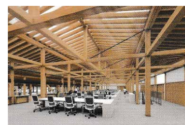
地元のスギやヒノキを最大限に活用し、柱や梁の木材を隠さず見せていく「木あらし」の内装になっている。
