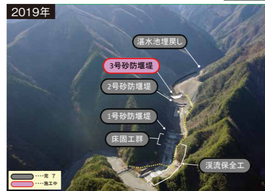
崩壊土砂量は東京ドーム9杯分に相当する約1,100万m 3 。1号・2号砂防堰堤と床固工群が完成し、現在は自動化施工を導入して3号砂防堰堤を構築している。 ※工事は取材時(令和3年(2021年)7月)現在の状況です。
