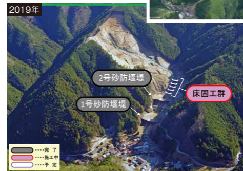
被害: 全半壊8棟 崩壊土砂量: 約117万m 3 河道閉塞: 高さ28m、幅130m
