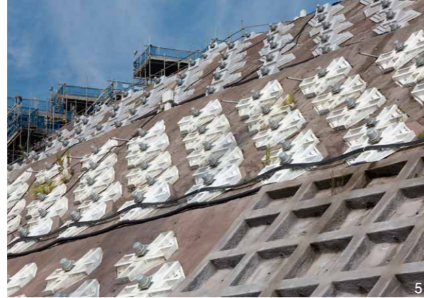
1. JV 工事事務所から見る取水施設の工事現場。2. コア材の盛立て現場で施工状況を確認・指示する鎌田JV所長(右)。3. GNSSや各種センサで検知した情報をモニター画面に表示し、盛立て施工をするバックホーなどの建設機械をICTで管理している。4. 取水放流施設などのコンクリート構造物の工事が進んでいる左岸側を視察。5. 地山の安定のために打たれたグラウンドアンカー。
