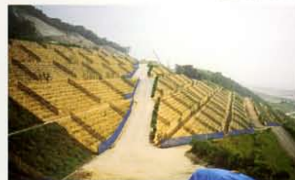
施工直後(撮影1994年7月)
