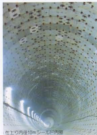
仕上がり内径10mシールド内部
