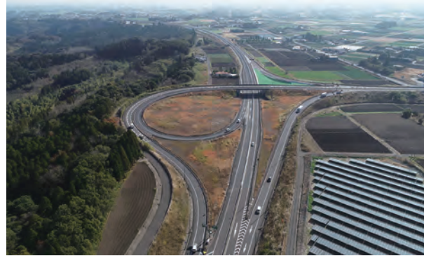
東九州自動車道 鹿屋申良JCTの整備(鹿屋市)
