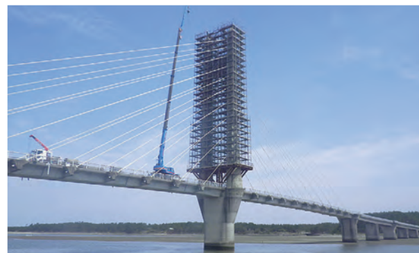
吹上浜サンセットブリッジの主塔部補修(南さつま市)
