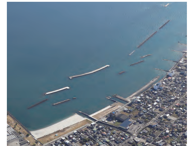
指宿港海岸の離岸堤・護岸の整備(指宿市・直轄)
