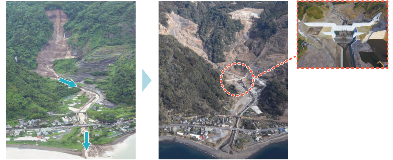
深港川の砂防堰堤整備(垂水市)
