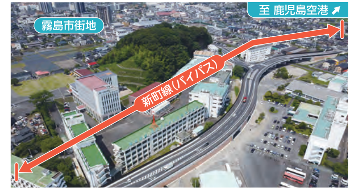
都市計画道路新町線のバイパス整備(霧島市)
