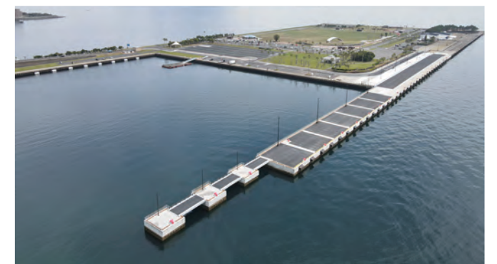
マリポートかごしまの第2岸壁の整備(鹿児島市)
