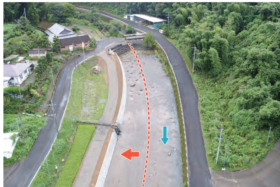
野田川の河道拡幅(出水市)
