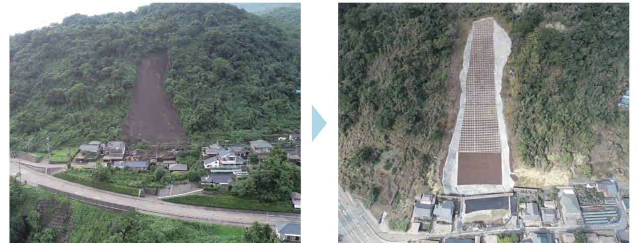
古里地区の法枠工整備(鹿児島市)
