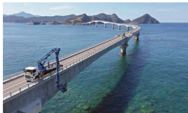
甌大橋の橋梁点検車による上部工点検(薩摩川内市)
