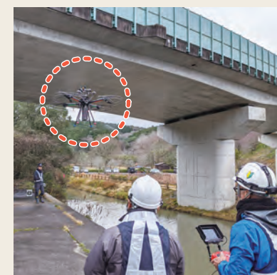
ドローンを活用した橋梁点検の試行
