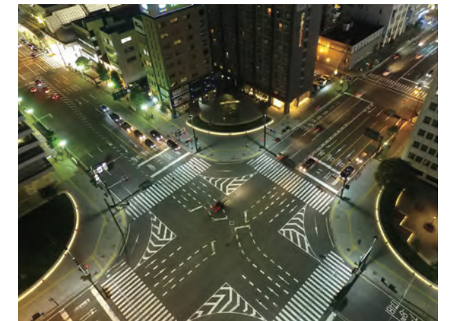
リノベーションプロジェクト/まちの魅力の再生とにぎわいの創出(大分昭和通り交差点四隅広場/大分市)
