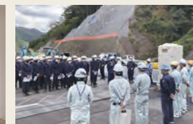
耶馬溪道路新設工事現場の見学
