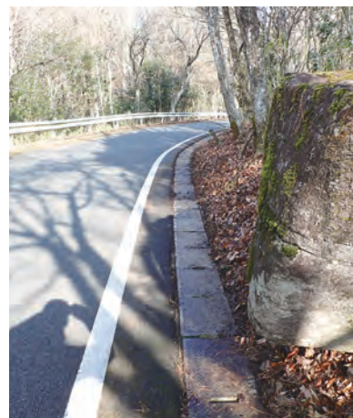
側溝蓋かけによる路肩拡幅 (県道下恵良九重線/玖珠町)
