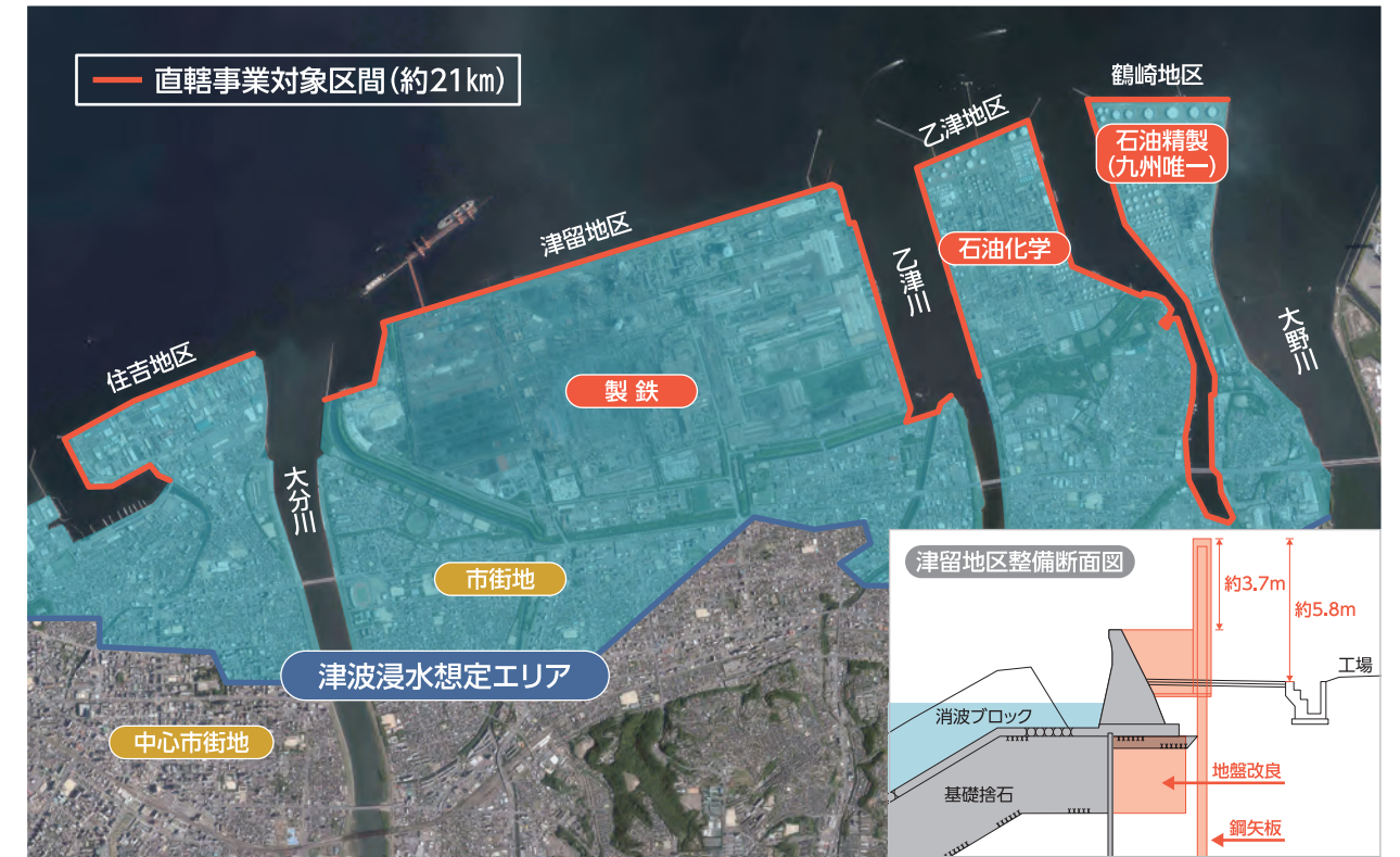
地震・津波、高潮被害に備えた海岸の整備／大分港沿岸
