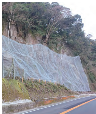
斜面崩壊対策 (国道212号/中津市)
