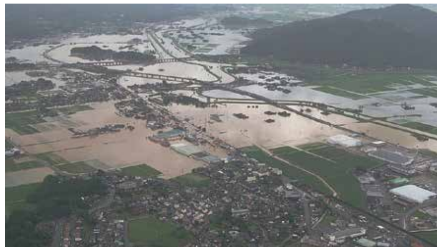
九州地方整備局はるかぜ撮影 長崎自動車道武雄インターチェンジ付近
