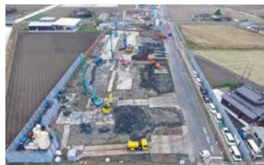
有明海沿岸道路(福富北IC~福富IC間 地盤改良・盛土)施工状況
