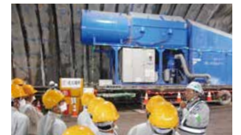
建設機械の役割もしっかり学習
