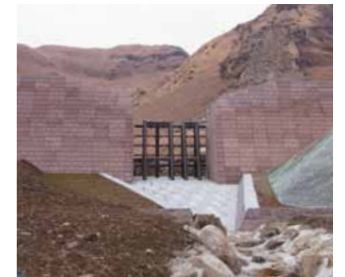
砂防堰堤(一里山川)(阿蘇市)
