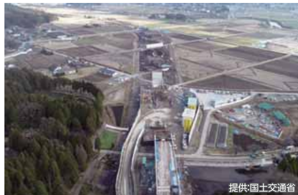
国道57号北側復旧ルート(阿蘇側坑口)／H30.12.18時点
