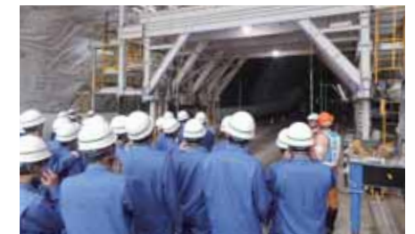
探検隊の気分でいよいよトンネルの中へ。
