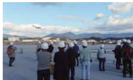
空港内でエプロン新設工事も見学。
