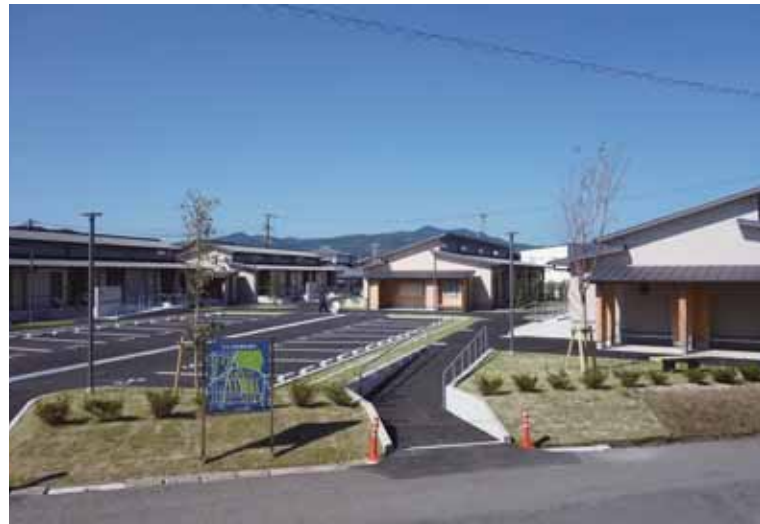
県が建設等を受託し完成した災害公営住宅(宇土市宮境目団地)／H30.9
