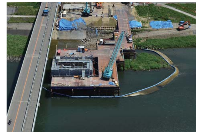
緊急輸送道路である県道高鍋高岡線の本床橋架け替え工事
