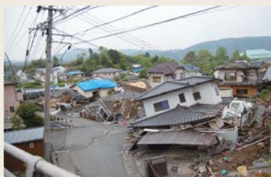
地震で倒壊した家屋
