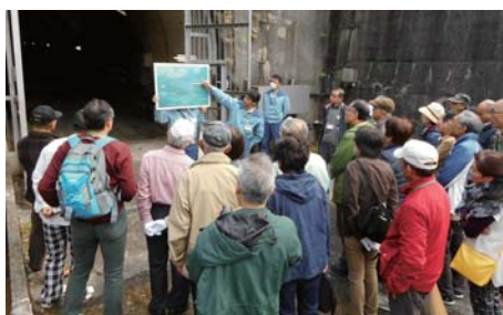
ダム下部に設けられた通路を通り堤体内部へ
