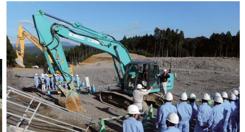
バックホウによるICT施工をじっくり見学
