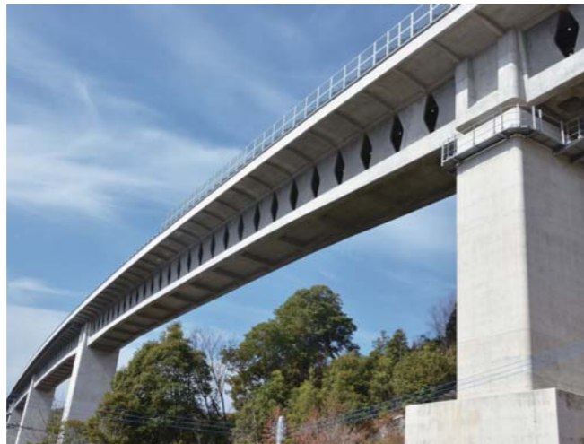
東九州自動車道(寺泊ちようちよ大橋)
