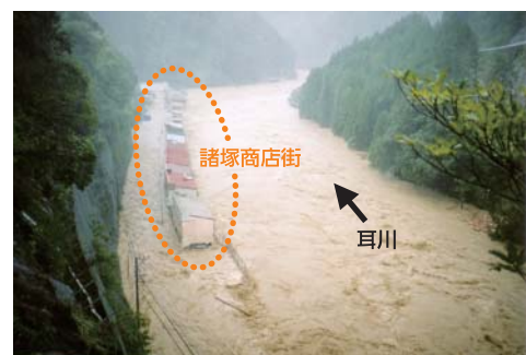
浸水被害の状況(H17.9)
