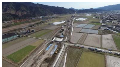
建設中の東九州自動車道 日南北郷IC付近
