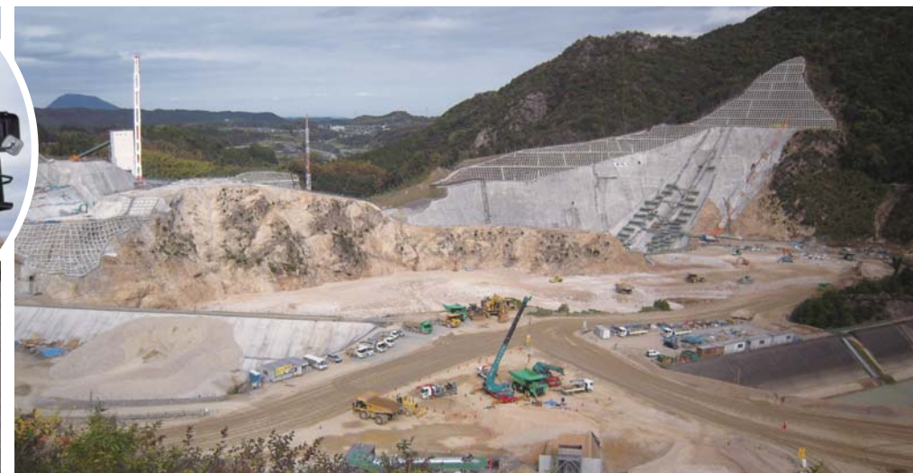
着々と建設が進む広大なダム工事現場
