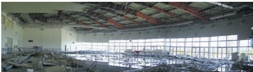
写真1 屋内プールの天井落下事故調査報告より
