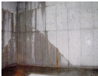
写真1 地下外壁からの漏水事例1
