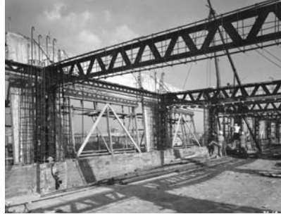
写真3 昭和初期の大型パネル吊り込み
