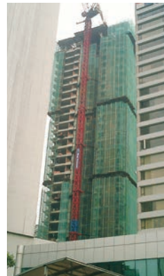
写真2 マレーシアの外部足場
