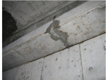
写真1 梁底に出たエフロ
