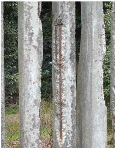
図2 中性化による鉄筋の腐食例
