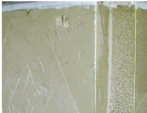
写真1 フィラー材の使用
