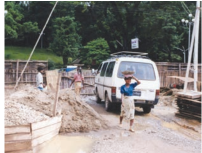
写真6 ミャンマーのコンクリート打ち
