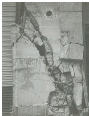
写真1 柱が塑性変型した例
