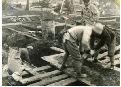
写真6 昭和初期の人力による掘削
