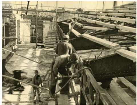
写真7 昭和初期のリベット打ち
