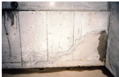
写真2 地下外壁からの漏水事例2
