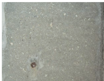
写真2 ダイヤモンドカップ掛け処理面
