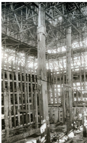
写真2 瓦柱組立完了
