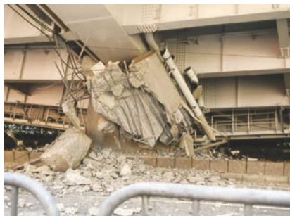
写真2 柱の激しい剪断破壊
