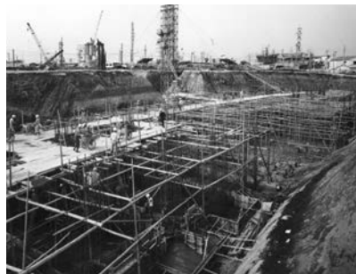
写真4 昭和初期のコンクリート打ち
