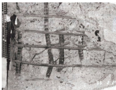
写真2 柱の塑性ヒンジ
