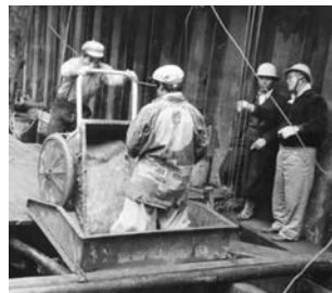
写真5 昭和初期のコンクリート打ち
