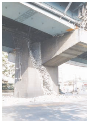
写真1 柱の剪断破壊
