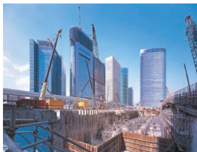
写真1 建設が進む超高層ビル群
