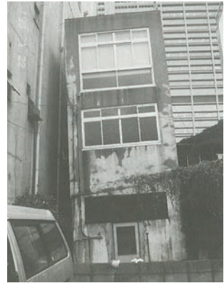
写真1 液状化によって傾斜した建物
