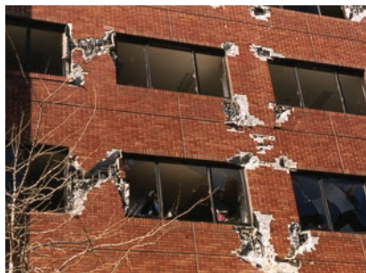
写真3 短柱化による剪断破壊
