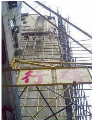
写真1 香港の竹足場
