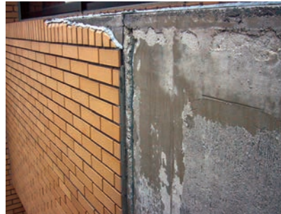
写真1 タイル剥落例
