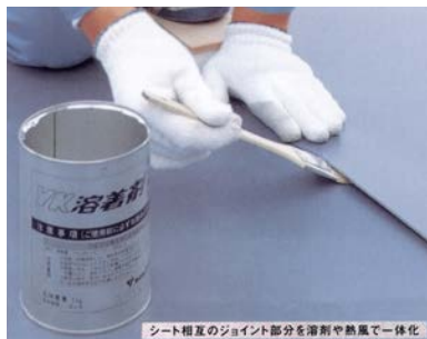
写真1 塩ビシート防水相互の溶融着
