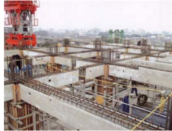
写真1 PCa施工状況
